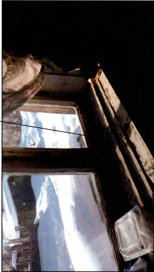
Оконные коробки поражены гнилью, усиление проёма отсутствует
